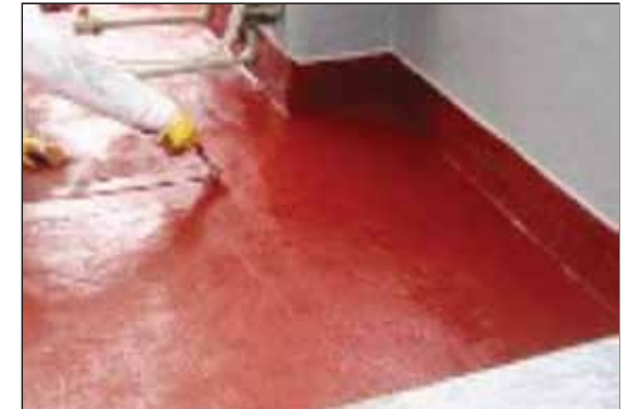
Aplicación de capa final de ARC CS4.
